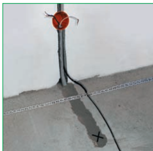
◀ Начало укладки кабеля Весь кабель уложен ▼
