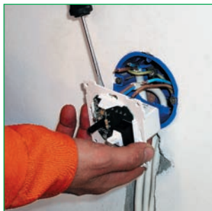
▲ Подключение терморегулятора
