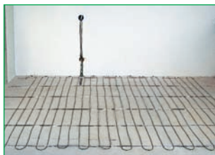
◀ Начало укладки кабеля Весь кабель уложен ▼
